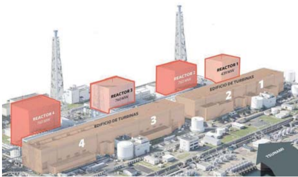
Ubicación de los reactores dentro de la planta.
