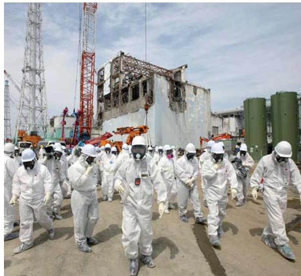
Trabajadores durante el proceso de limpieza y estabilización de la planta.
