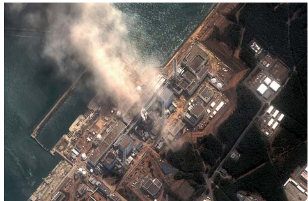
Vista aérea de la central nuclear Fukushima I poco tiempo después del tsunami.
