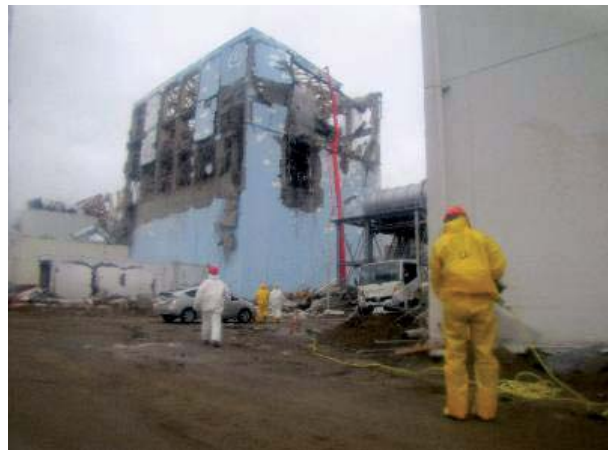
Trabajadores durante las actividades de estabilización de la planta nuclear.
