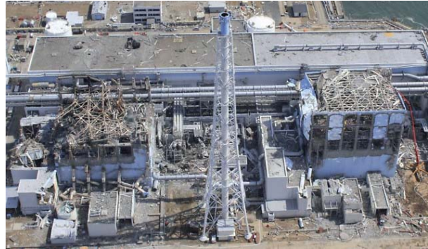
Vista de los daños a las estructuras de los edificios de los reactores nucleares de Fukushima.
