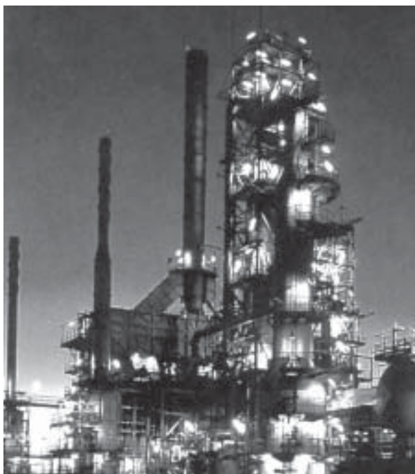
Fig. 1. Instalaciones de una industria petroquímica típica.
