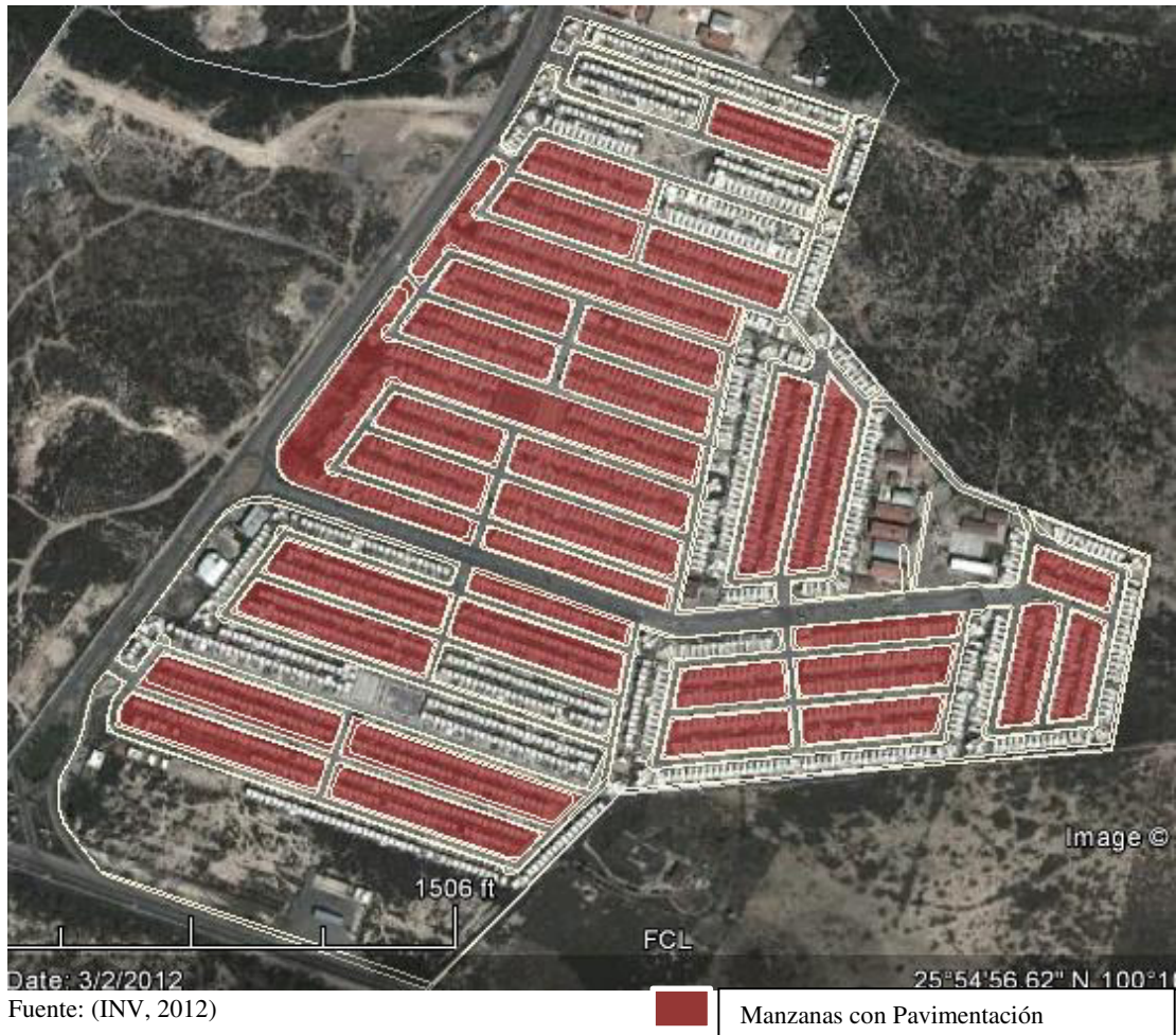
Fig.3. 23 Pavimentación Fracc. Villas De Alcalá, Gral. Zuazua, N.L.
