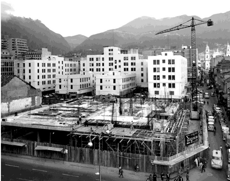
Construcción de edificio de carácter moderno para oficinas en la esquina de la carrera 10ª con calle 11. Al fondo, a la derecha, se aprecian las torres de la catedral primada de Bogotá. C. 1957. Fuente: Museo de Bogotá.
