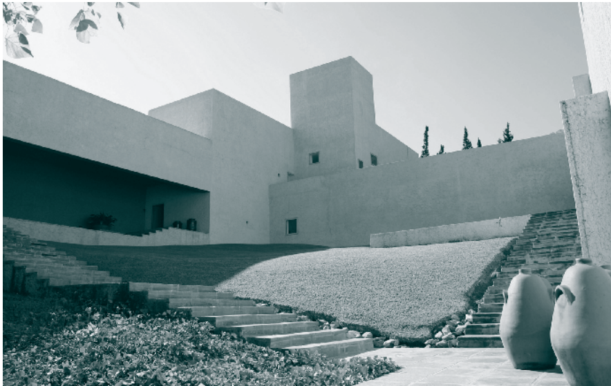
FIG. 15. BARRAGÁN + FERRERA, CASA VALDÉS-CANALES , MONTERREY, 1981-83. FOTOS. R. L.
