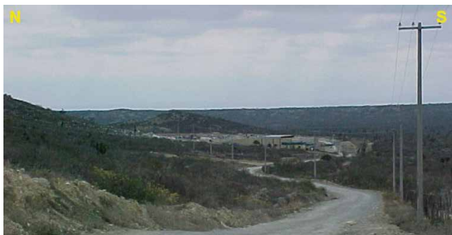
Figura 8. Sobrevista del relleno sanitario municipal, Linares, N.L.
