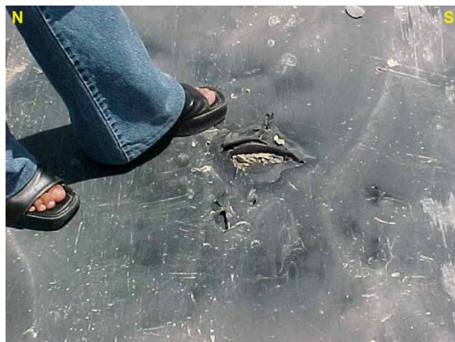
Figura 9. Geomembrana del RSM, nótese la ruptura generada por la operación de maquinaria pesada. Coordenadas UTM: 452,300E, 2'745,700N.
