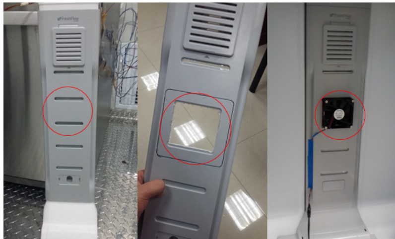
Figura 6.20: Zona de modificación del ducto
