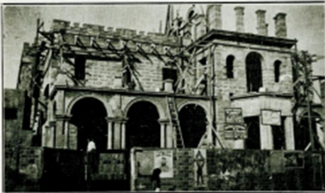
Bloques huecos de concreto de «La Victoria» en una obra en Monterrey.
