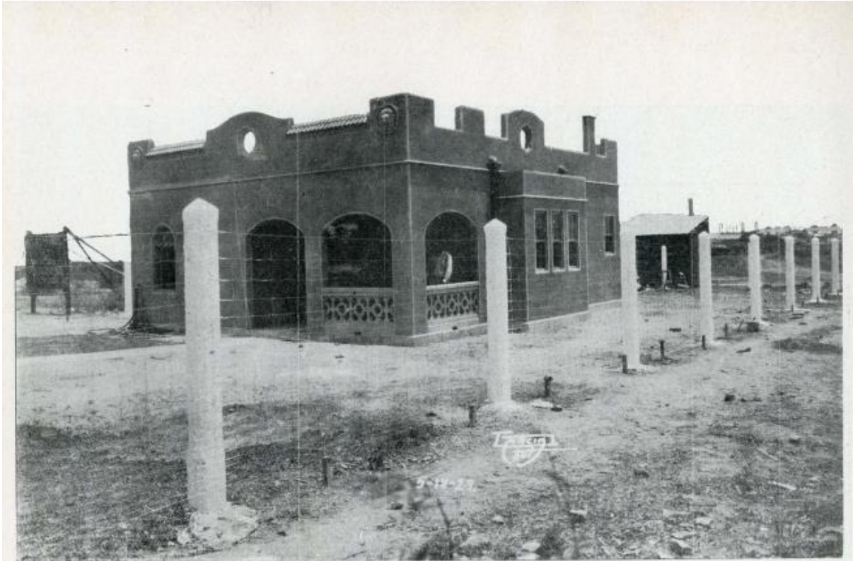
Una de las casas que formarán en Monterrey, N. L., la Colonia de los empleados y obreros de la Cervecería Cuauhtémoc. Estas casas son construídas en su totalidad con productos de concreto manufacturados por los Sres. Muguerra Hnos., S. en C.
