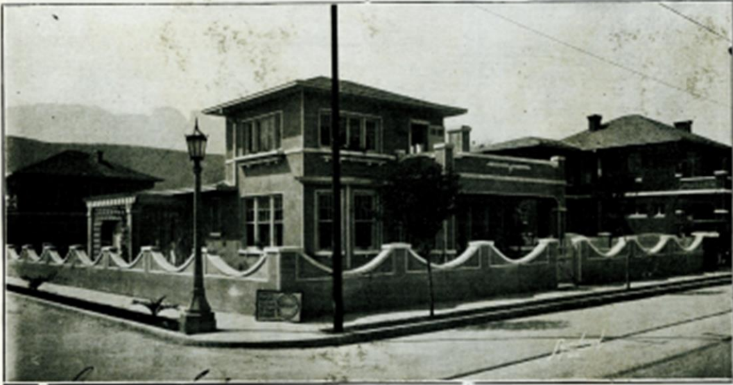
Colonia El Mirador en Monterrey. Casas y arbotantes de concreto.
