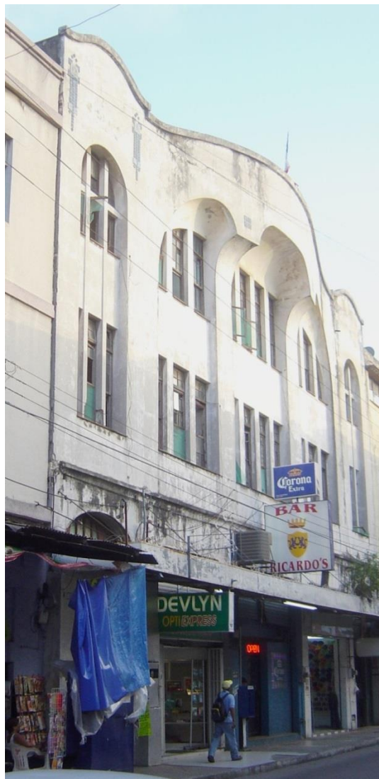
LUPERCIO CRUZ, Carlos; Edificio multifamiliar calle Aduana entre Altamira y Álvaro Obregón; Tampico, Tamps., 2015.
