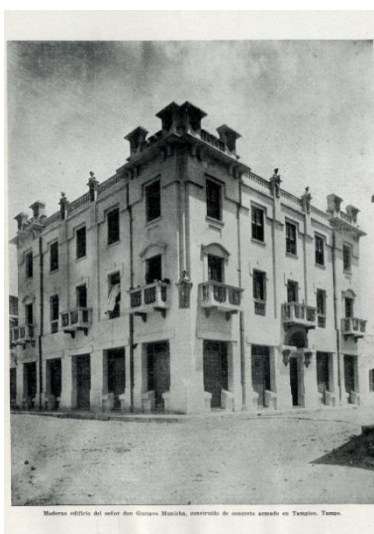
Fot. SANDOVAL, "Edificio Gustavo Municha"; Cemento .
