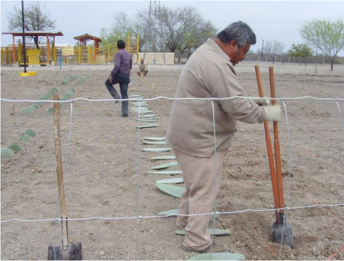
Fotografía 11. Excavación de los pozos.
