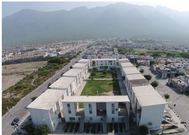
FIGURA 03. Vista aérea de un módulo compuesto por 5 departamentos, 2 en planta baja y 3 en planta alta
