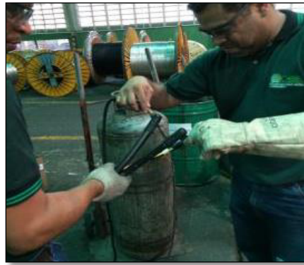
Figura 42. Aplicación de capuchón termo-contráctil en planta ICV. [42]
