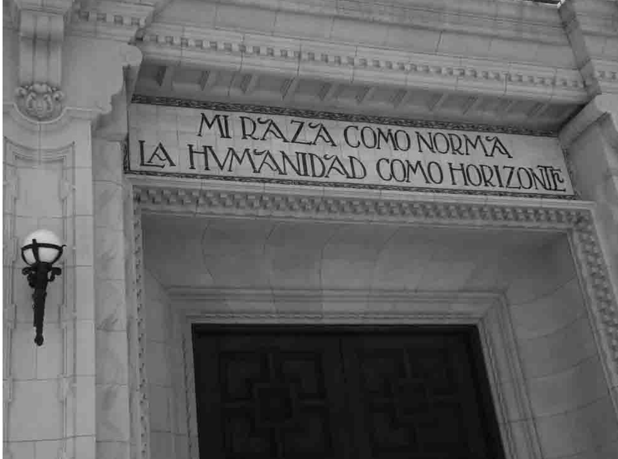
■ Fachada del Colegio Civil con el lema original de 1933: “Mi raza como norma. La humanidad como horizonte”.
