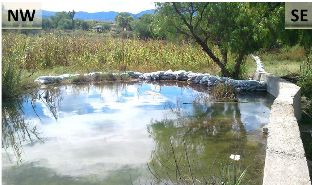
Figura 9. Barrera de contención para controlar el desborde al NE de la laguna. Derecha: Dique de concreto con conexión al desagüe de la laguna.
