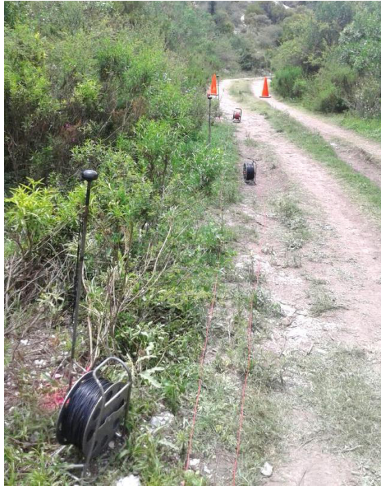
Figura 58. Tendido de cables y electrodos a través del área de interés en la Línea L3 Taraises.
