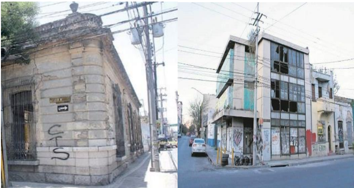
Fotografía 1. Vista de inmuebles abandonados afectados por el vandalismo en el Centro de Monterrey Fuente: Archivos de Milenio Y ABC noticias
