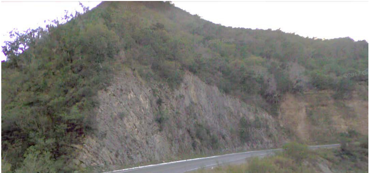
Figura 24. Fotografía panorámica de la sección levantada en la localidad de la Cañada Guadalupe, Iturbide, Nuevo León, México (Tomado de Google, Inc., 2008).
