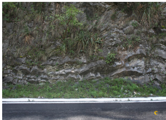
Figura 64. a) Fotomicrografía de la muestra ICM_5_33_43, mostrando algunos de los aloquímicos encontrados y vetas de mineral; b) Fotografía de la lámina delgada para la capa 33; c) Fotografía de la capa en el afloramiento.
