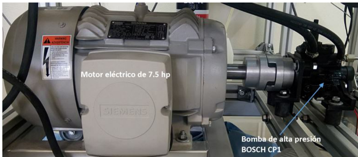
Figura 4.50: Motor eléctrico y bomba de alta presión.
