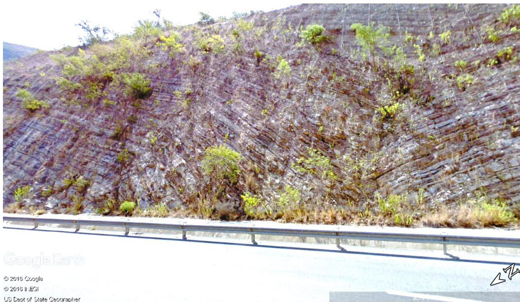
Ilustración 49.- Corte realizado en la unidad de Rocas Intercaladas, Talud 7, Km. 12+100. Margen izquierda.
