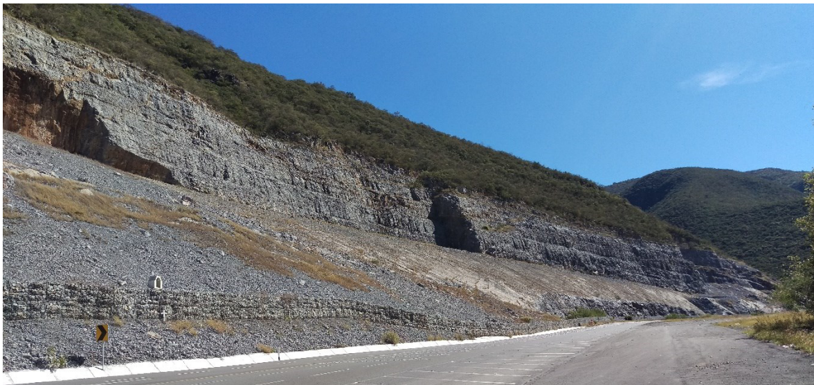
Ilustración 3.- Cortes por medios mecánicos y explosivos al macizo rocoso de la Fm. Tamaulipas Inferior. UTM 14 Q 484646.78 m E 2609960.90 m N.
