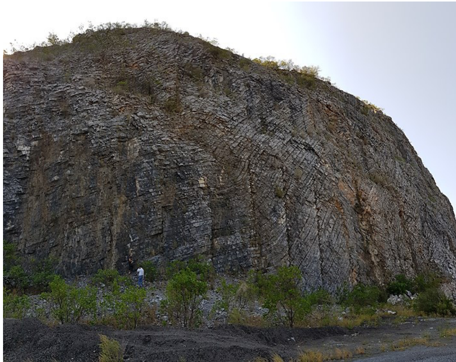
Ilustración 51.- Corte realizado en la Unidad de Rocas Intercaladas, en la Fm. Cuesta del Cura, Km. 12+350, Talud 8.
