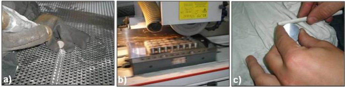
Figura 4.3. a) Proceso de limpieza mediante arena a presión, b) desbaste de superficie mediante fresadora y c) desbaste manual de bordes.
