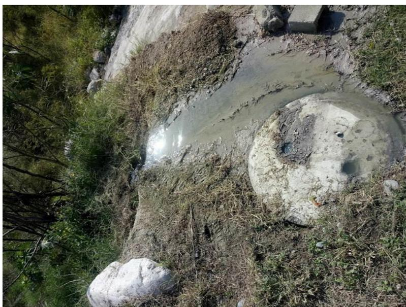
Figura 112. Derrame de drenaje sanitario vertido directamente hacia el río (O26).
