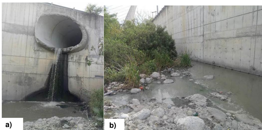
Figura 121. a) Descarga de aguas residuales D49 y b) Aguas negras” provenientes de la D49.
