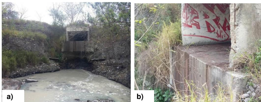
Figura 124. a) Aparente descarga de residuos fecales y b) Residuos fecales en descarga de agua residual D91.
