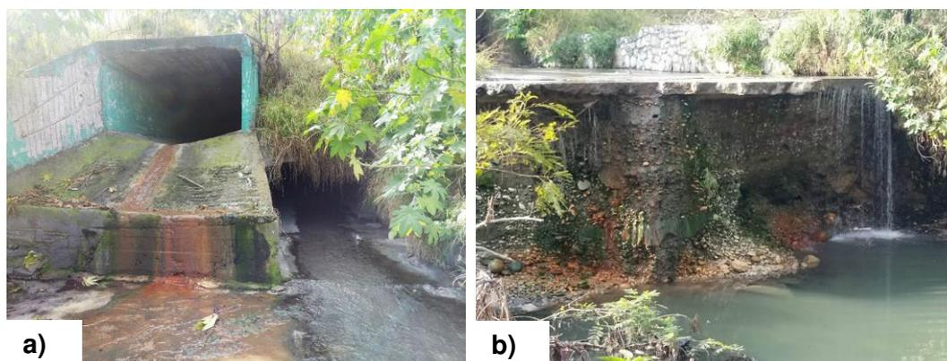
Figura 108. a) Descarga D78d con coloraciones café y rojizas y b) Alteración en la T2Mty, producto del contenido en la descarga D78d.
