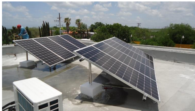
Figura 22. Paneles solares con inclinación de 25° sobre la horizontal.
