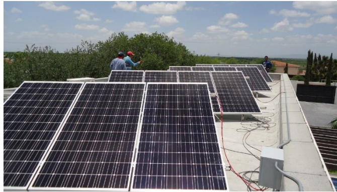
Figura 21. Instalación de los 15 paneles solares.
