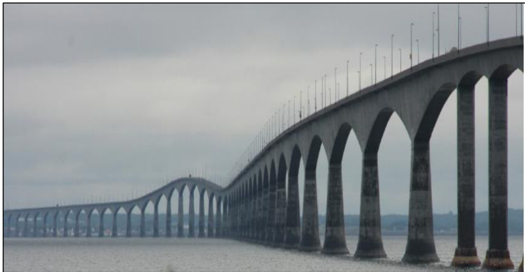
Fig. 3. Puente Confederación en Canadá [14]
