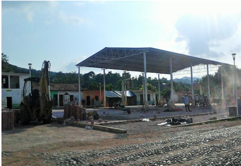
Fotografía propia: Trabajos de adoquinamiento de la Cancha de Presidio de los Reyes, Ruíz Nayarit.
