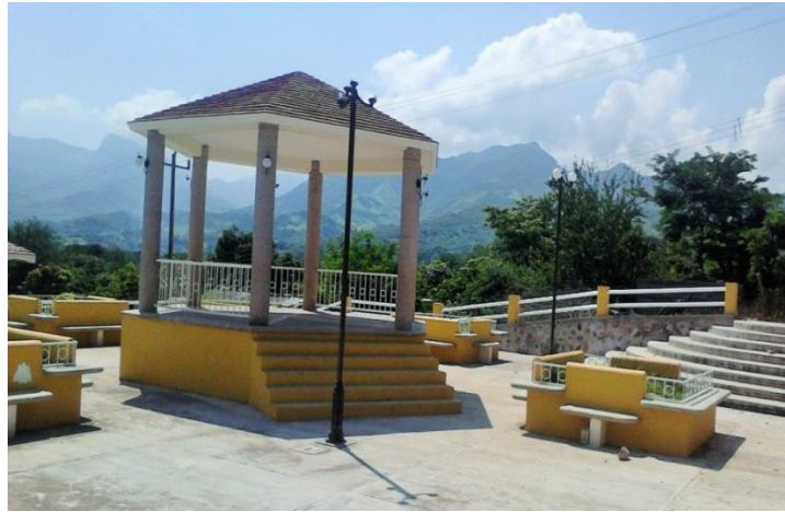
Fotografía propia: Remodelación de la plaza de la comunidad de San Juan Corapan, Rosamorada, Nayarit.
