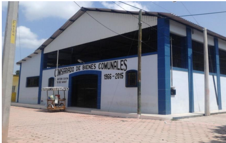
Fotografía propia: Adoquinamiento de calles laterales del Comisariado Ejidal en la comunidad de San Pedro Ixcatán, Ruíz, Nayarit.
