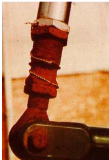
Figura2.11 Oxidación en un ajustador de barra de seguimiento de acero, después de que se produjo daño en el recubrimiento de cadmio protector [68]
