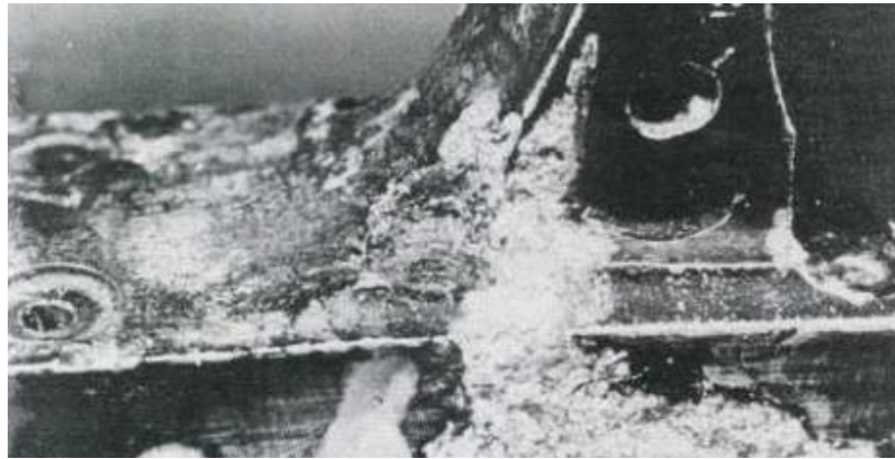
Figura 2.12 Corrosión por picadura [73]
