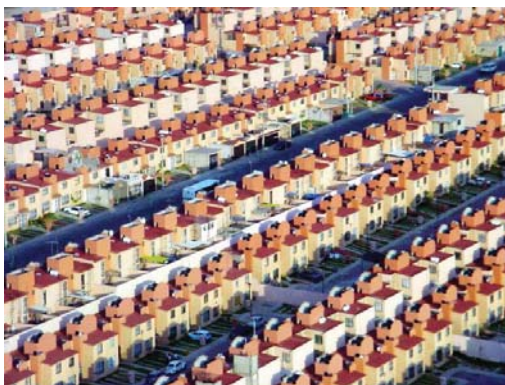
Figura 1. Casas GEO, en Tultitlán, Estado de México, fuente:
