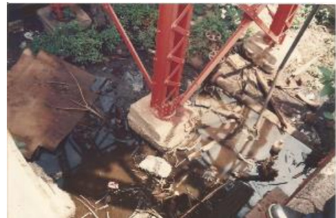
Figura 18. Mezcla de residuos peligrosos.
