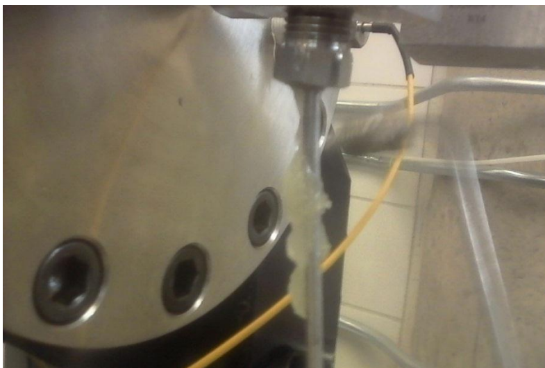
Figura 5.6 derrame de PPG al quitar una conexión en la línea de salida.
