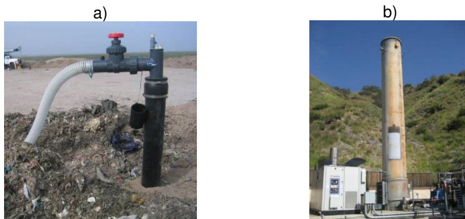
Figura 3. Partes del sistema de captación de biogás en rellenos sanitarios, a) Cabeza del pozo de extracción y b) estación de quemado [13].
