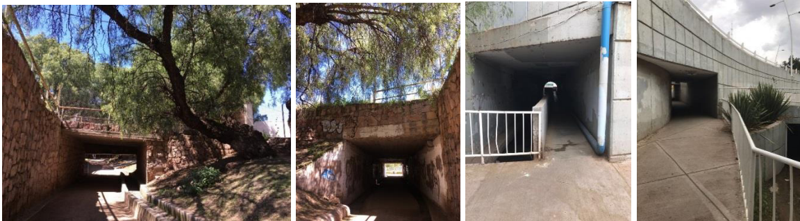
Figura 141. Túneles de Sección C
