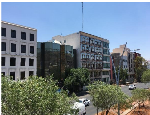
Figura 66. Edificación sobre Boulevard
