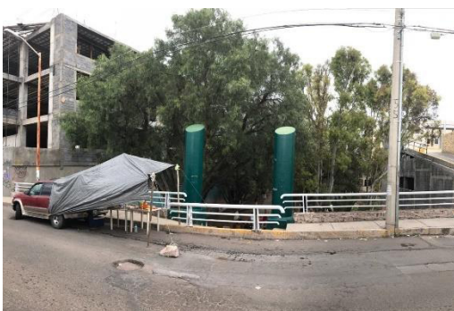
Figura 93. Acceso a sección desde supermercado
