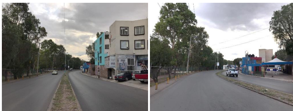
Figura 100. Área libre de edificación hacia sección B
