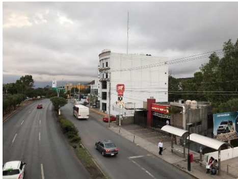
Figura 104. Edificación comercial en boulevard
