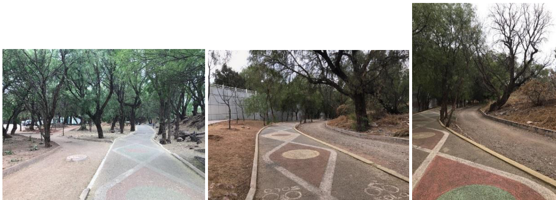
Figura 143. Estado de pistas interiores, Sección C
