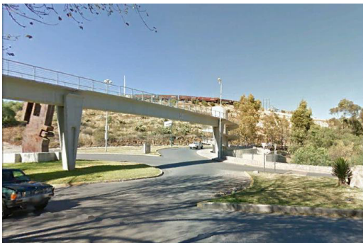
Figura 61. Puente en García Salinas
