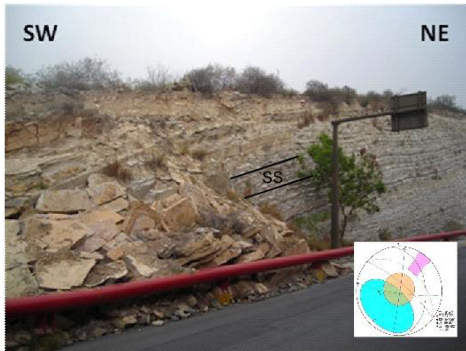
Figura 39. Talud # 7, en esta imagen se observa en la parte SW un talud ya fallado por un mecanismo de tipo planar.
