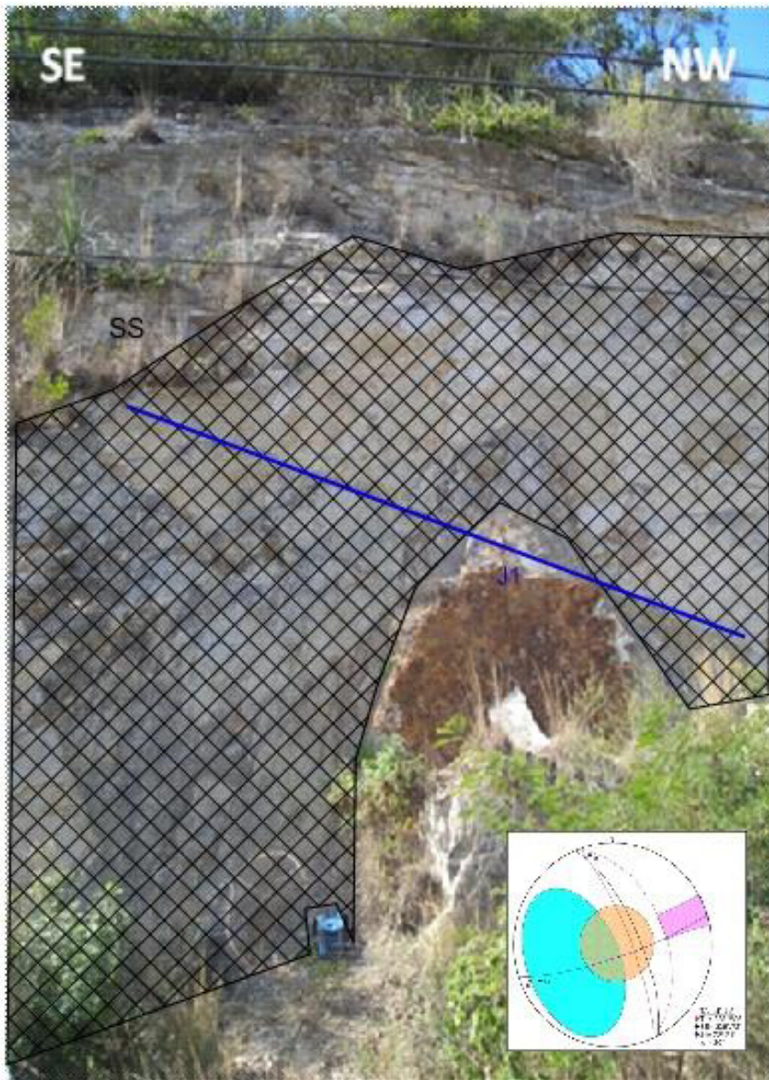
Figura 35. Talud # 5, Se puede observar el material arcilloso en su parte superior cubierta por vegetación y en el talud descubierto por el desgajamiento del mismo.
