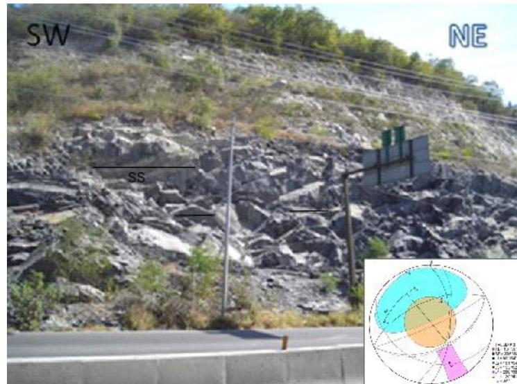
Figura 31. Talud # 3, en esta imagen podemos observar la estratificación de calizas, los cuales van de delgados a mediano.
