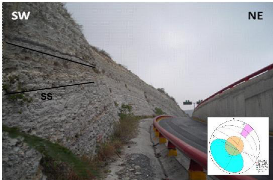
Figura 37. Talud # 6, en esta imagen se observa un talud construido para un tramo carretero en una curva.
