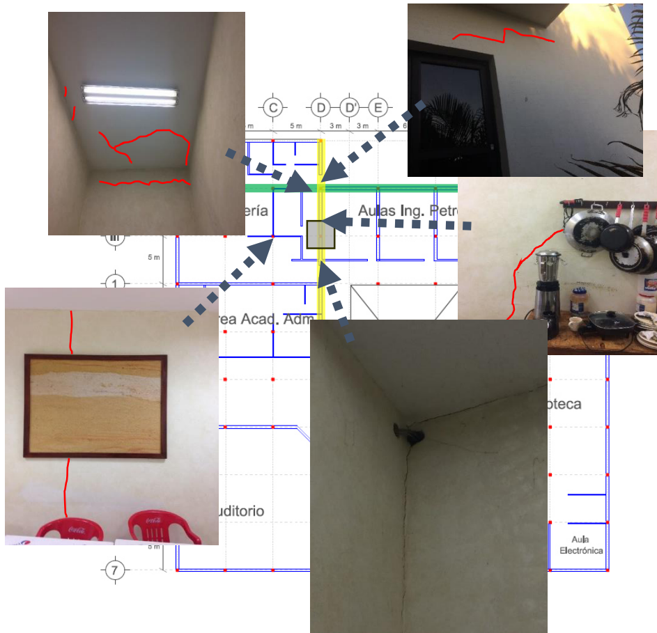
Figura 4.19 Fracturamiento producido por el asentamiento diferencial en la Zapata D-III
