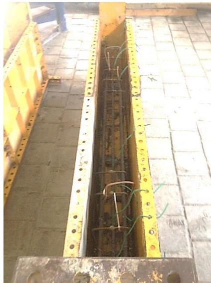
Figura 22: Cimbrado y habilitado de acero de refuerzo.
