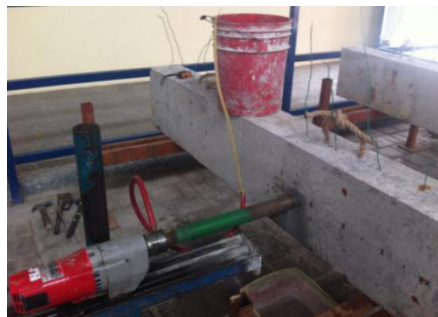
Figura 29: Equipo utilizado para la extracción de corazones.
