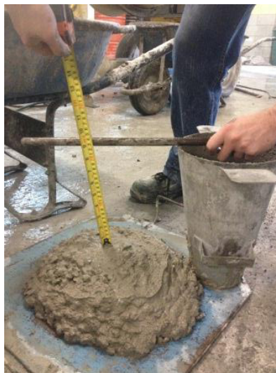
Figura 18: Prueba de revenimiento en concreto fresco.
