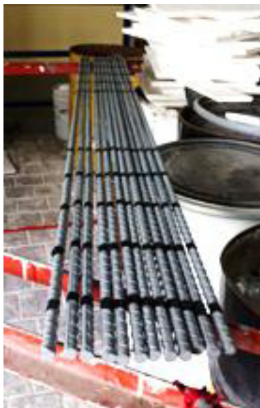
Figura 21: Varillas longitudinales de 5/8" preparadas para evitar su deterioro
