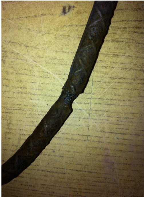
Figura 9: corrosión localizada (picadura)
