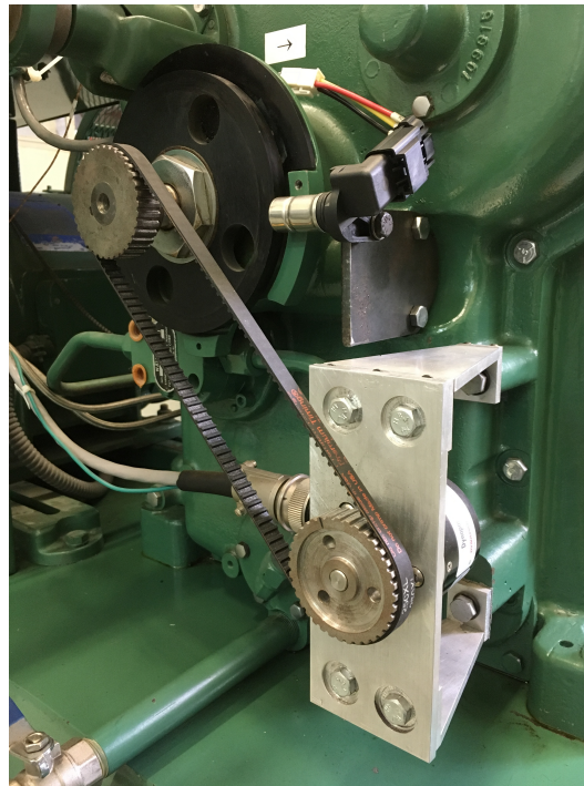
Figura 3.7: Instalación del encoder incremental y sensor de uno por vuelta.
