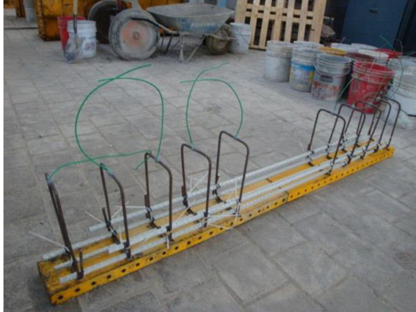
Figura 15. - Arreglo del acero de refuerzo previo al colado.
