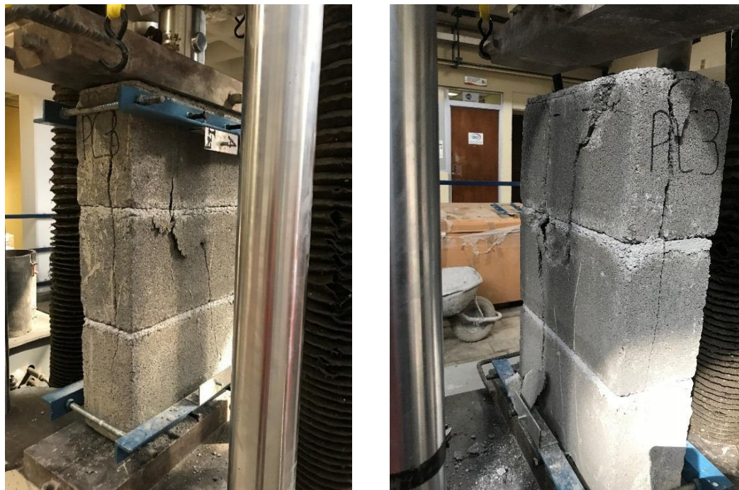
Figura 27. Patrón de agrietamiento en pilas.
