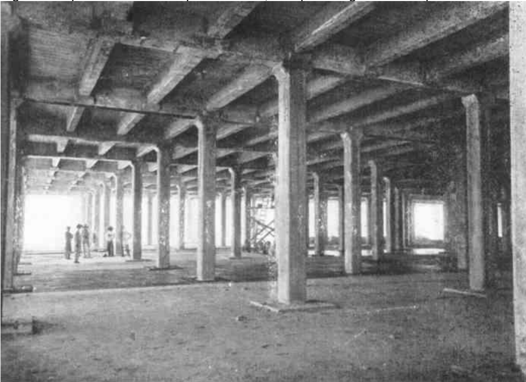
Fig. 26. Preparación del suelo para vaciado, Tanque de agua del Obispado.
