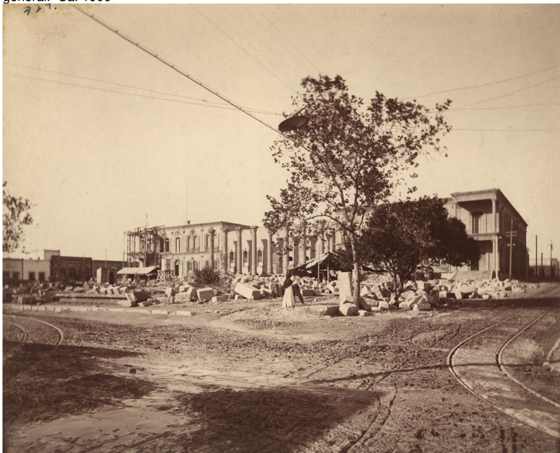
Fig. 20. Desiderio Lagrange. Plaza Cinco de Mayo y Palacio de Gobierno en construcción, vista general. Ca. 1900
