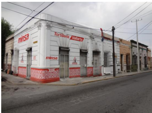
Figura 102. Banquetas insuficientes y riesgosas.
