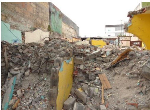
Figura 104. Imagen urbana, Deterioro y abandono.
