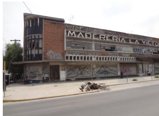
Figura 63. Abandono de patrimonio arquitectónico.
