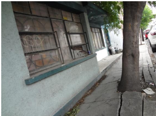
Figura 100. Obstrucción de banquetas y abandono.
