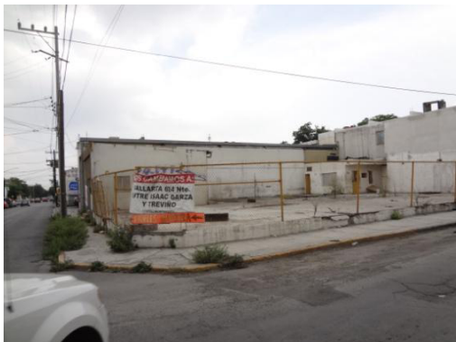
Figura 98. Sub-utilización y abandono urbano.
