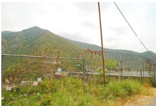
Foto 25. La Cortina Sector: Presa de la Boca Rodrigo Gómez
