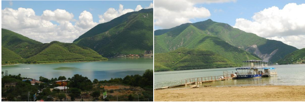
Foto 20. Panorámica de la Presa de la Boca Sector: Presa de la Boca Rodrigo Gómez
