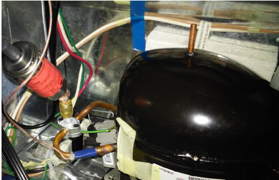
Figura 5.11: Válvula de servicio y transductor instalado en la succión del compresor.
