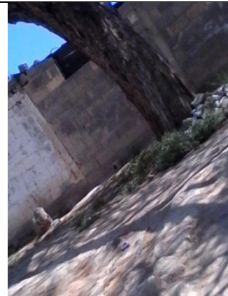
Una vista de la otra esquina donde también se aprecian las manchas de color naranja, en ambos frentes de la vivienda
