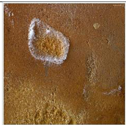
Imágenes tomadas muy de cerca a las manchas anaranjadas, evidenciado la presencia de sustancias alcalinas como también eflorescencia
