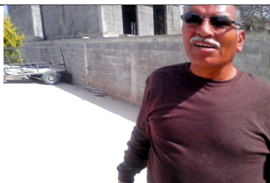
Vivienda de clase media alta pero que presenta fisuras en piso y en pared que da a fachada principal
