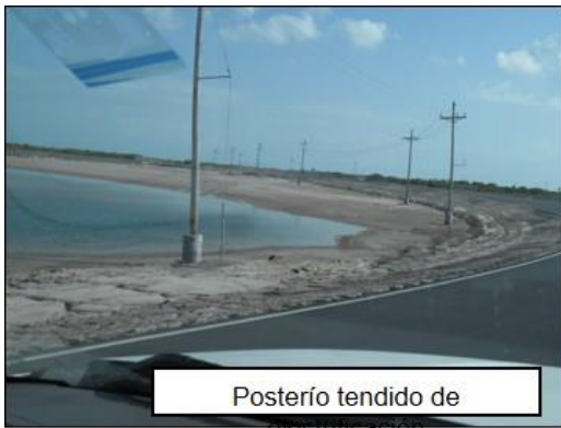
Figura 3.30 Infraestructura de servicios: electricidad, agua potable, drenaje y pavimentación. Fuente: Reporte fotográfico propio 2016.
