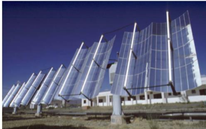
Figura 8.- Colectores solares cilindro-parabólicos con seguimiento en dos ejes, modificados para tratamiento fotocatalítico de agua
