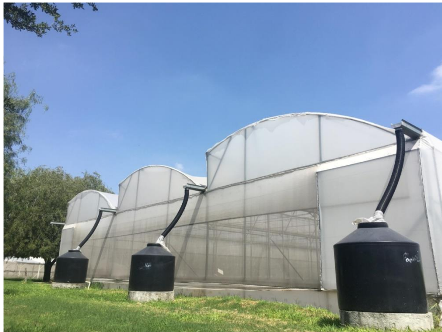
Figura 1. Invernadero del Centro de Agricultura Protegida, FAUANL
