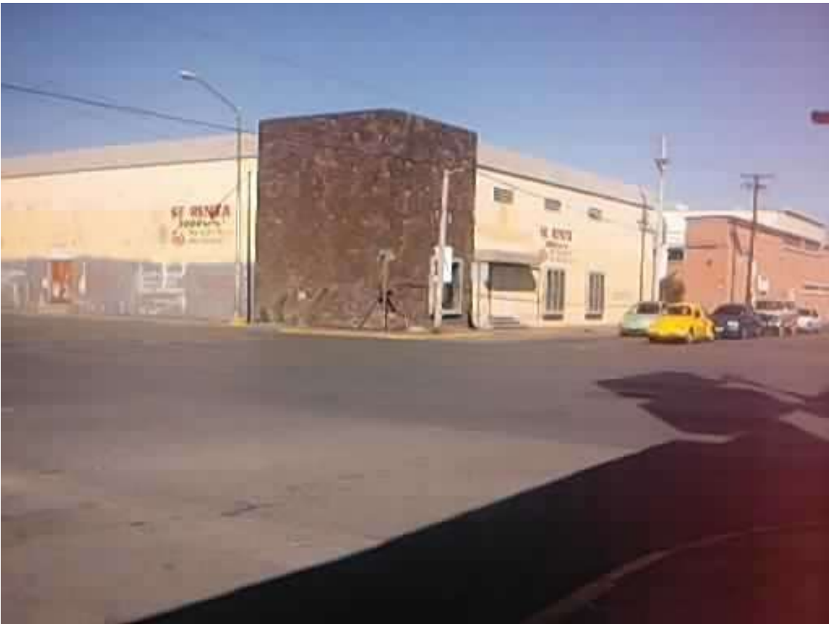
Anexo número trece: Fachada de la nave industrial por la avenida Insurgentes
