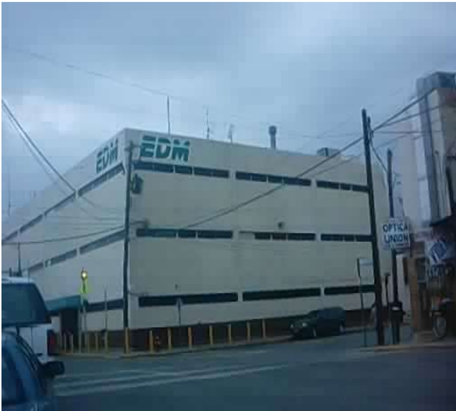
Anexo número diez y siete: Fachada de la nave Industrial ubicada en Avenida Lerdo y calle Abraham González
