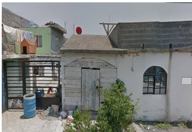
Foto 1. Vivienda unifamiliar, ubicada en colonia Gloria Mendiola, Monterrey, Nuevo León, México. Fuente: google map).
