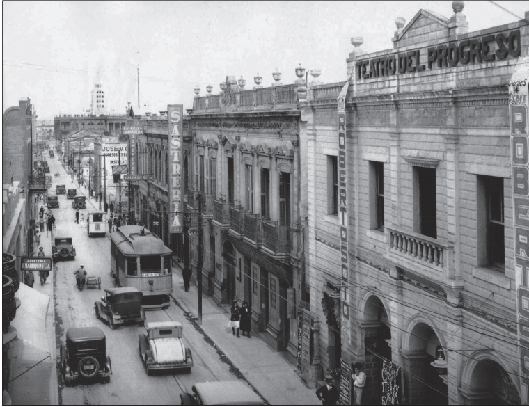
Figura 4. Teatro del Progreso, vista hacia el norte.
