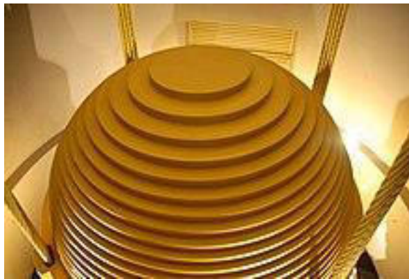
Figura 2.11: Amortiguador de Masa Sintonizado en el Edificio Taipéi 101 instalado en la cima [30]
