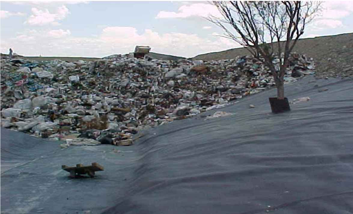
Figura 1.8 Corte hecho en la geomembrana para conservar vegetación de la zona (árbol). Actualmente este árbol ha sido cubierto por la basura. Coordenadas 452300 E y 2745700 N
