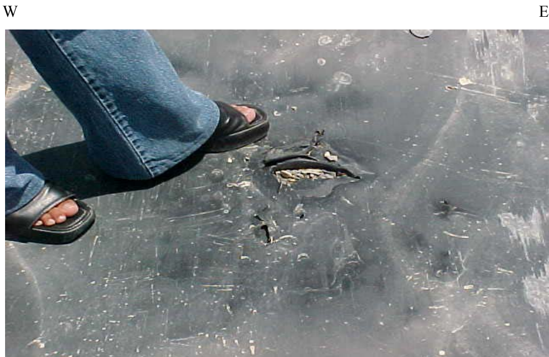
Figura 1.7 Geomembrana instalada en el Relleno Sanitario, obsérvese la ruptura que ha sufrido debido al paso de maquinaria pesada, en la operación del relleno sanitario. Coordenadas 452300 E y 2745700 N
