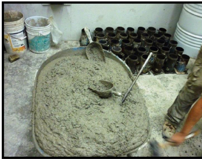
Fig.71 Transportación del concreto
