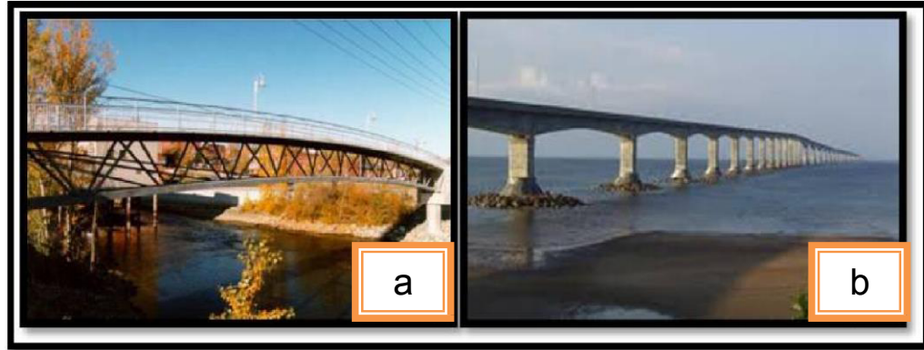
Fig. 7 a) Pasarela de Sherbrooke (Quebec, Canadá) b) Puente de la confederación (Islas Puerto Príncipe, Canadá).
