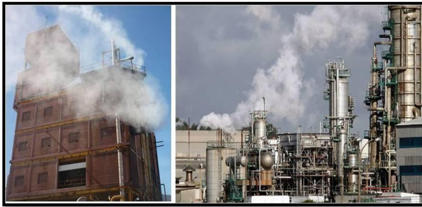
Fig. 38 Las estructuras industriales son más vulnerables al ataque químico por iones cloruro
