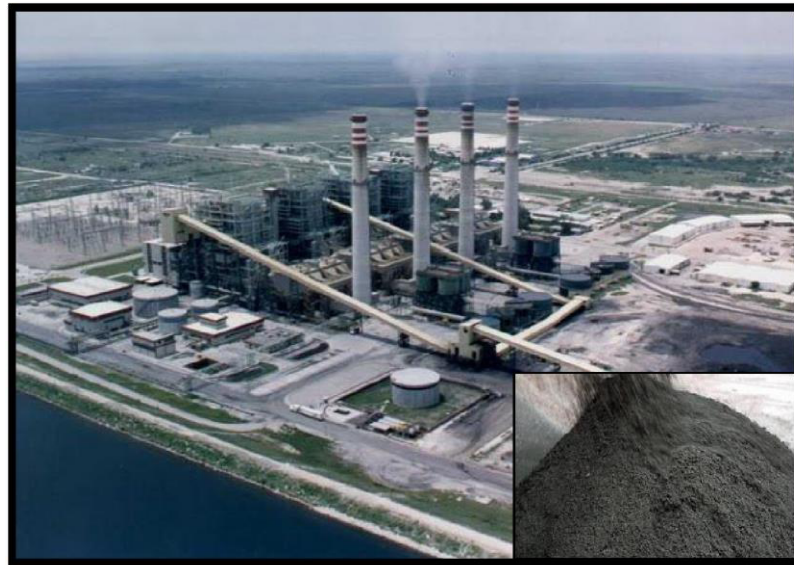
Fig. 55 Planta generadora de energía, de donde proviene la ceniza volante.
