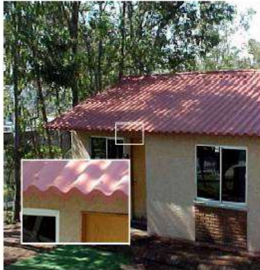
Fig. 5 Aislamientos en el techo para lograr una mejor eficiencia energética
