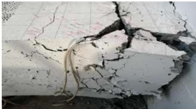
Fig. 105: Vista lateral, lado derecho de la viga con fibras de acero.
