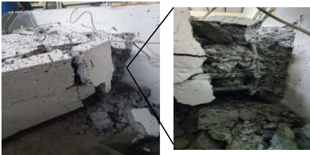
Fig. 104: Vista lateral, lado derecho de la viga sin fibras de acero.
